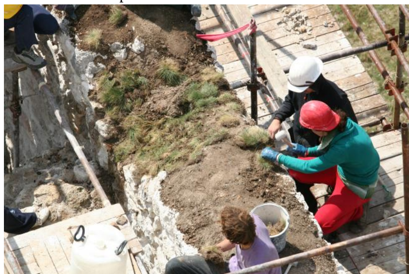
Obr. 8 Spôsob zatrávňovania koruny múru - najprv navrstvením humóznej
