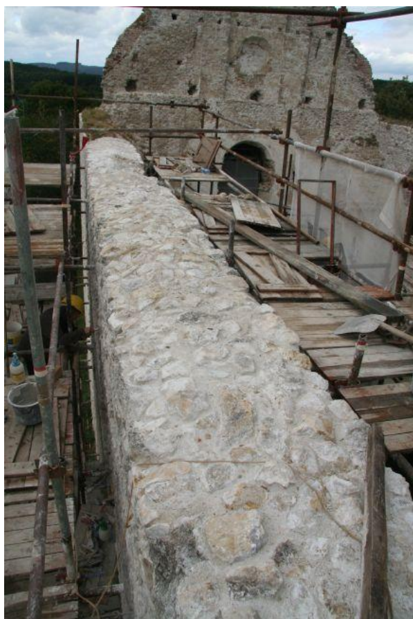
Obr. 10 Koruna západného múru lode kostola - stav po premurovaní koruny, ktorá je pripravená na zatrávnenie. 2009.
