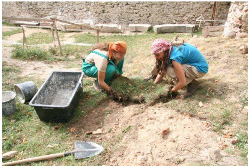
Obr. 7 Na biosanáciu korún múrov boli použité aj trávnaté koberce zo zeme bezprostredne pod múrmi na prevažne deštruovanej sutine vápennej malty, 2009.
