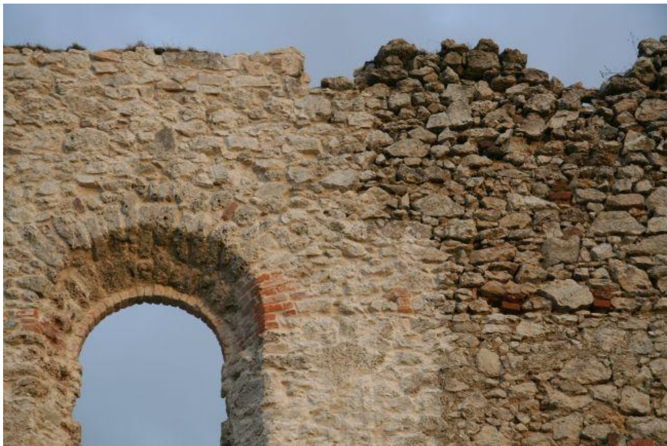
Obr. 2 Detail západného bočného múru – rozdiel medzi neškárovaným a škárovaným murivom, 2008.
