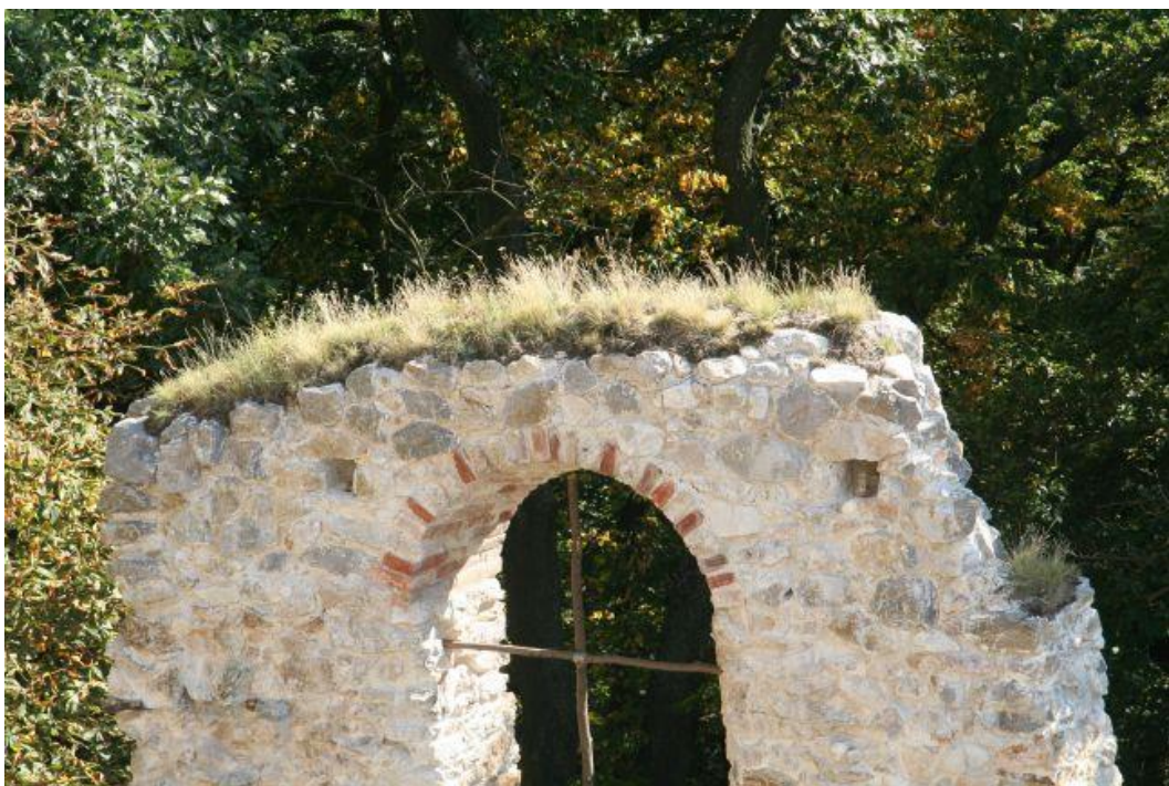
Obr. 9 Koruna múru zatrávnená v roku 2007, stav po 2 sezónach v roku 2009.
