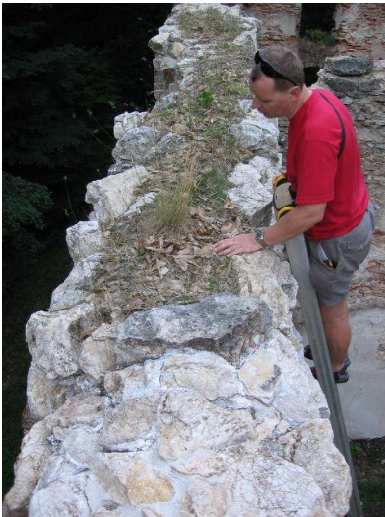
Obr. 5 Južný múr južnej časti kláštora - experiment s rôznymi spôsobmi riešenia koruny murív vrátane zatrávňovania - kontrola stavu statikom I. Holubom, 2006.
