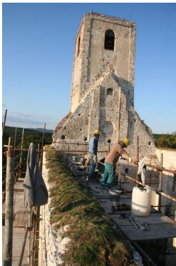
Obr. 11 Koruna západného múru lode kostola - finálny stav po zatrávnení, 2009.
