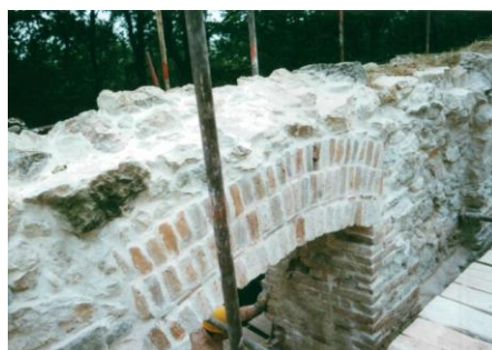
Obr. 6a Rekonštrukcia záklenku okna na druhom podlaží kláštora – stav pred zásahom, 2003.
