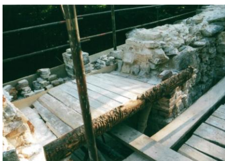
Obr. 6a Rekonštrukcia záklenku okna na druhom podlaží kláštora – stav pred zásahom, 2003.
