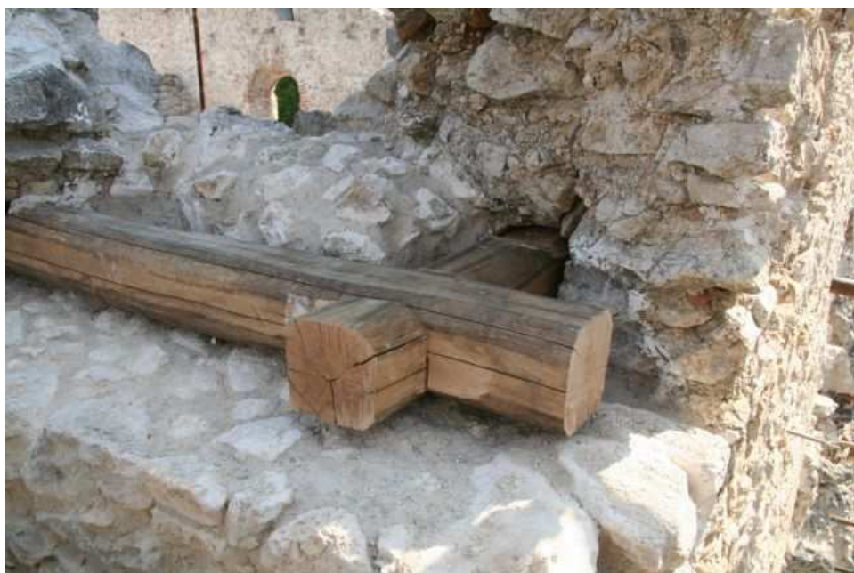
Obr. 16 Ručne kresané dubové trámy ako náhrada pôvodnej rozpadnutej stužujúcej statickej konštrukcie, 2009.
