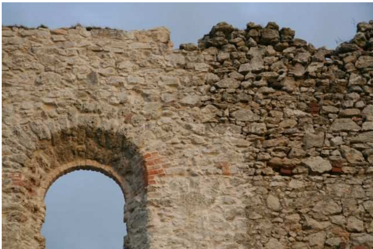
Obr. 20 Detail západného bočného múru – rozdiel medzi neškárovaným a škárovaným murivom, 2008.
