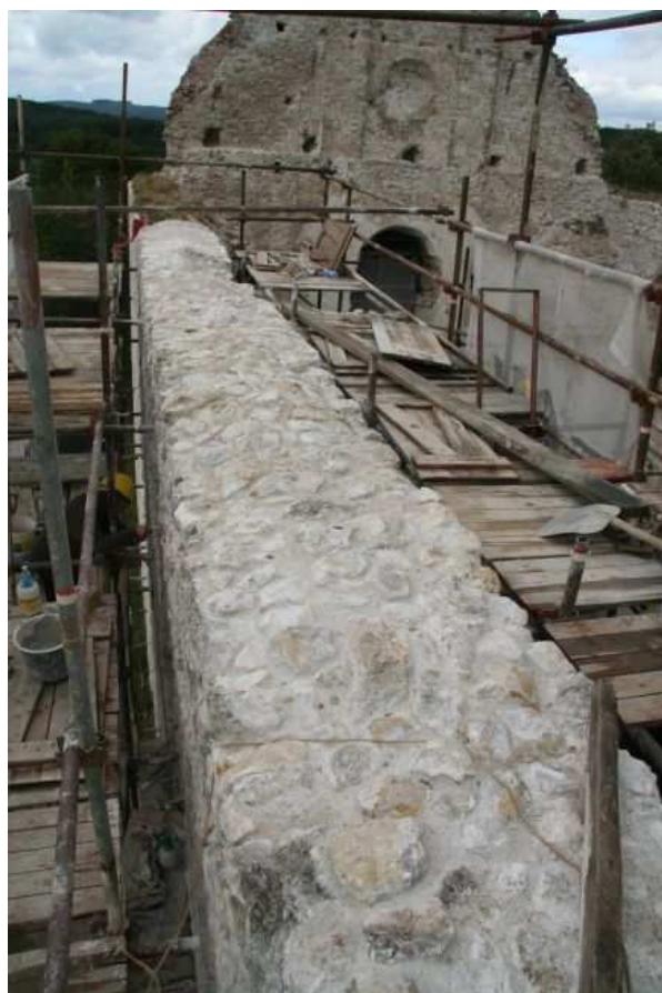
Obr. 33 Koruna západného múru lode kostola - stav po premurovaní koruny, ktorá je pripravená na zatrávnenie. 2009.
