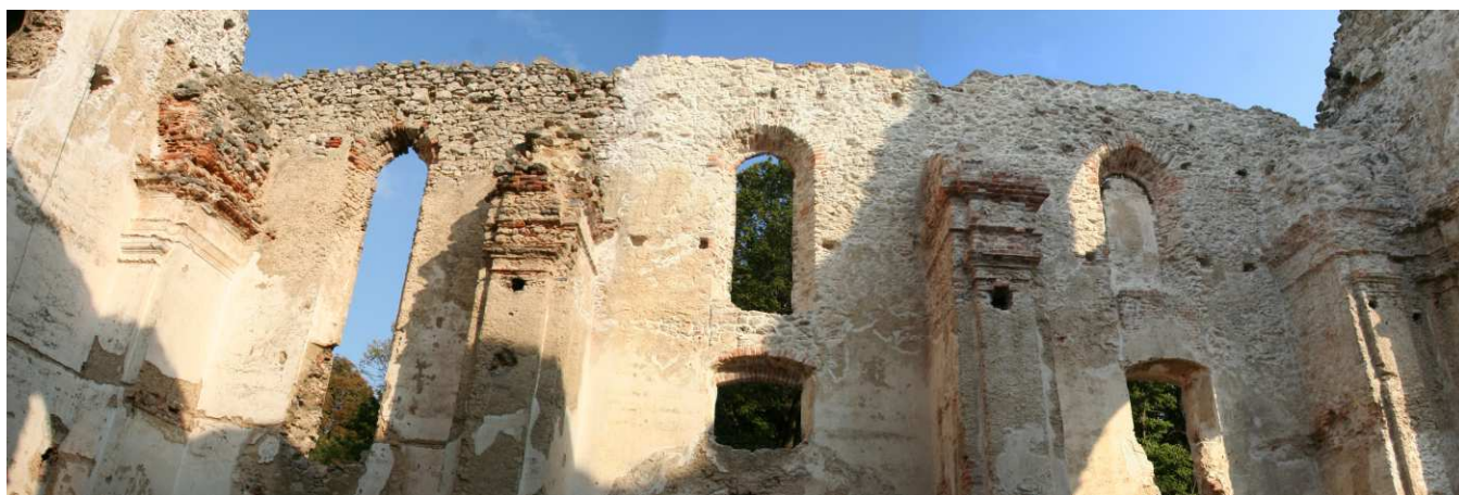
Obr. 19 Interiér východného múru kostola - stav po konzervácii väčšej časti, plošnom preškárovaní, rekonštrukcii ozdobných ríms a statickom zaistení hlavíc pilierov, 2006.
