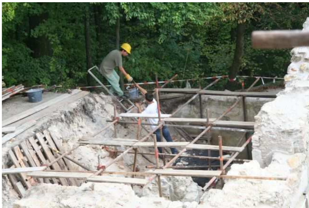
Obr. 43 Zakrývanie archeologickej sondy pomocou montovanej priestorovej lešenárskej konštrukcie, 2009.
