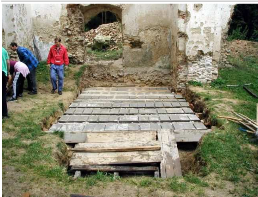
Obr. 41 Krypta počas zakrývania stropnými nosníkmi, ktoré po zaliatí betónom vytvorili kompaktný krycí panel, izolovaný a zasypaný vrstvou zeme na úroveň terénu, 2001.
