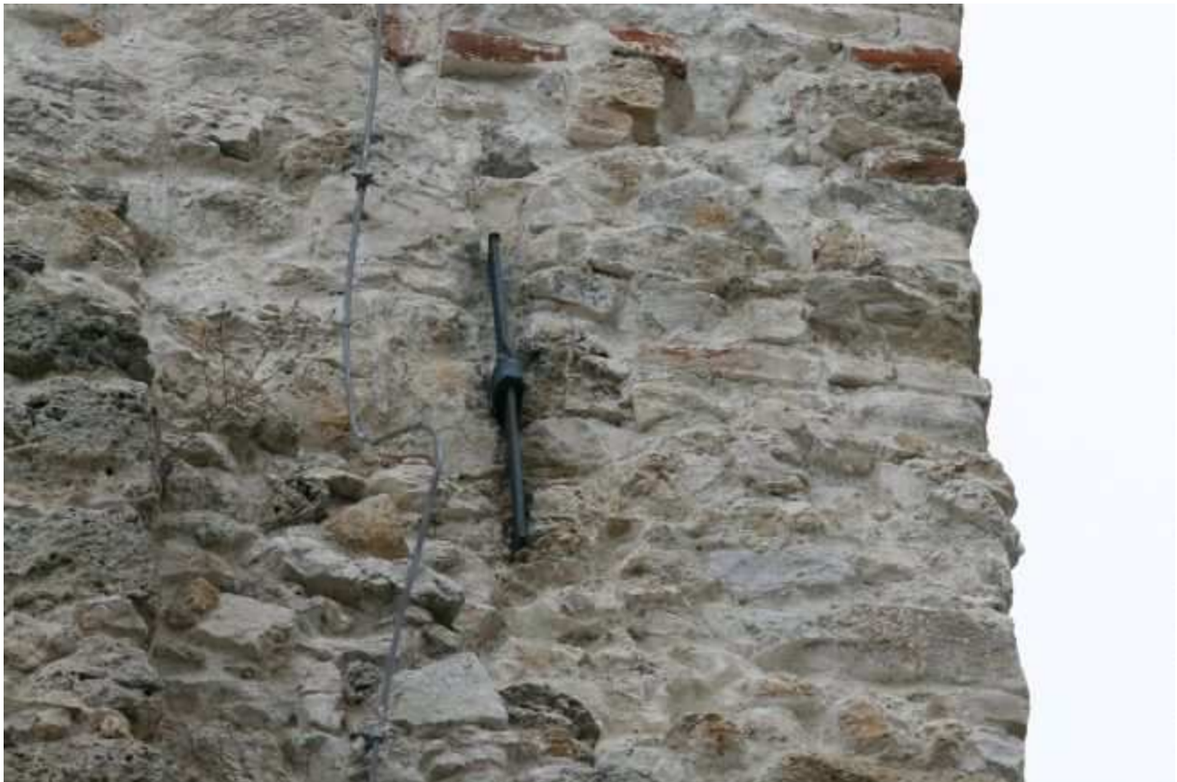
Obr. 17 Pôvodná statická konštrukcia na nároží veže - detail kovovej závlačky osadenej na konci tiahla. Naľavo nanovo osadený hromozvod.
