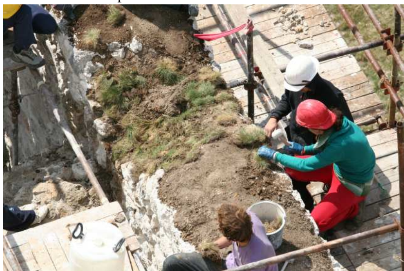
Obr. 31 Spôsob zatrávňovania koruny múru - najprv navrstvením humóznej
