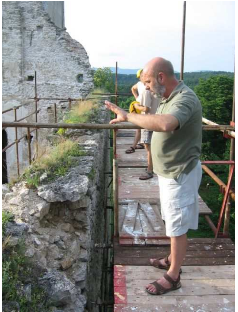
Obr. 28 Profil degradovanej koruny muriva - postupné ubúdanie vyplavenej malty smerom ku lícam múru a následná deštrukcia až do jadra, na korune vidno pôvodné zatrávnenie. Obhliadka statikom V. Kohútom, 2006.
