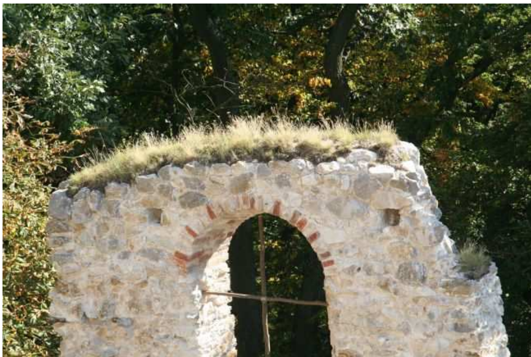
Obr. 32 Koruna múru zatrávnená v roku 2007, stav po 2 sezónach v roku 2009.
