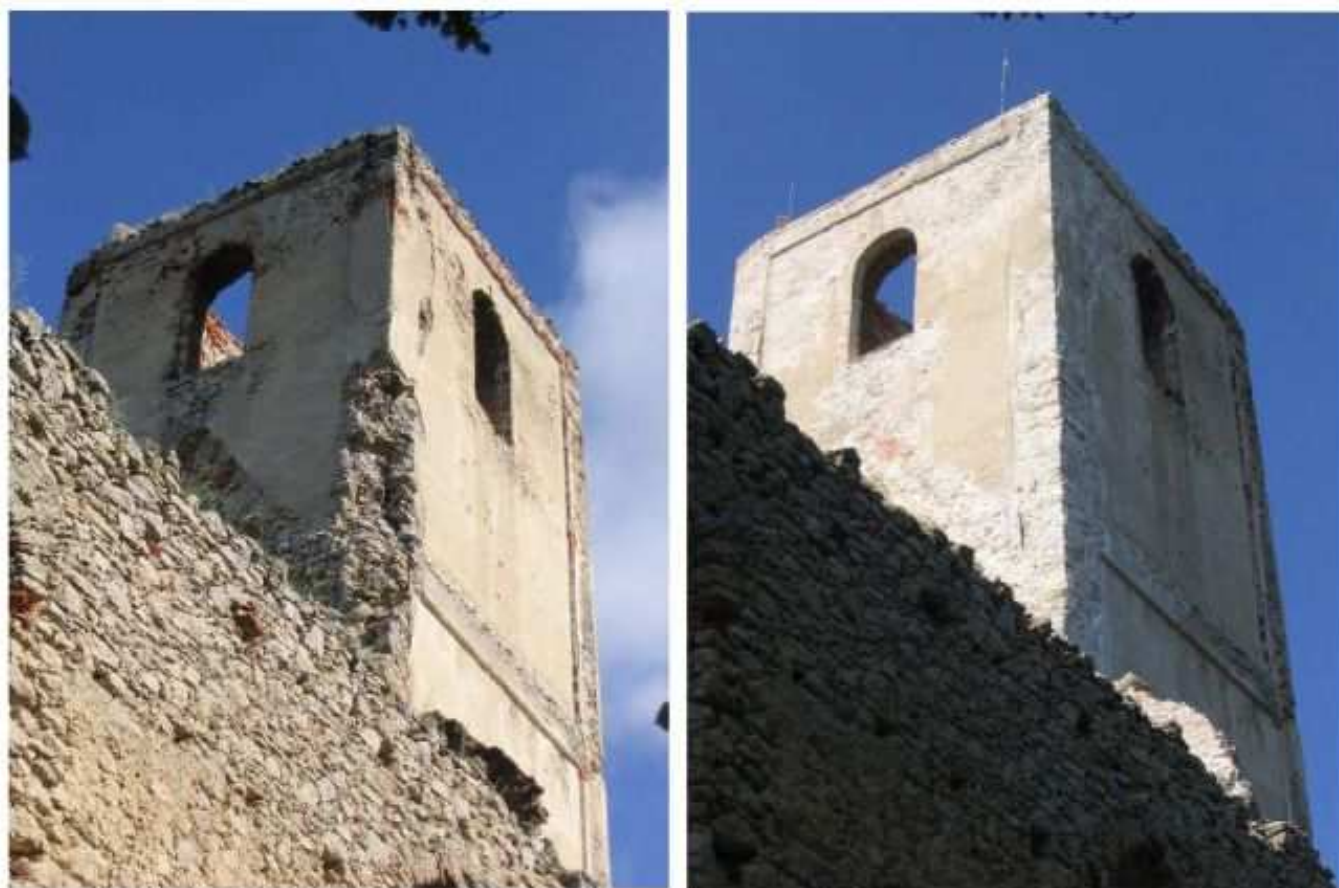
Obr. 26 Juhovýchodné nárožie veže - stav pred zásahom a po realizovaní kotvenia, rekonštrukcie a plošného škárovania, 2005.
