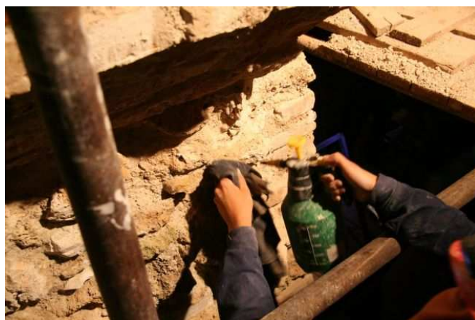
Obr. 22 Začistenie muriva ihneď po preškárovaní pomocou tlakovej striekačky, 2008.
