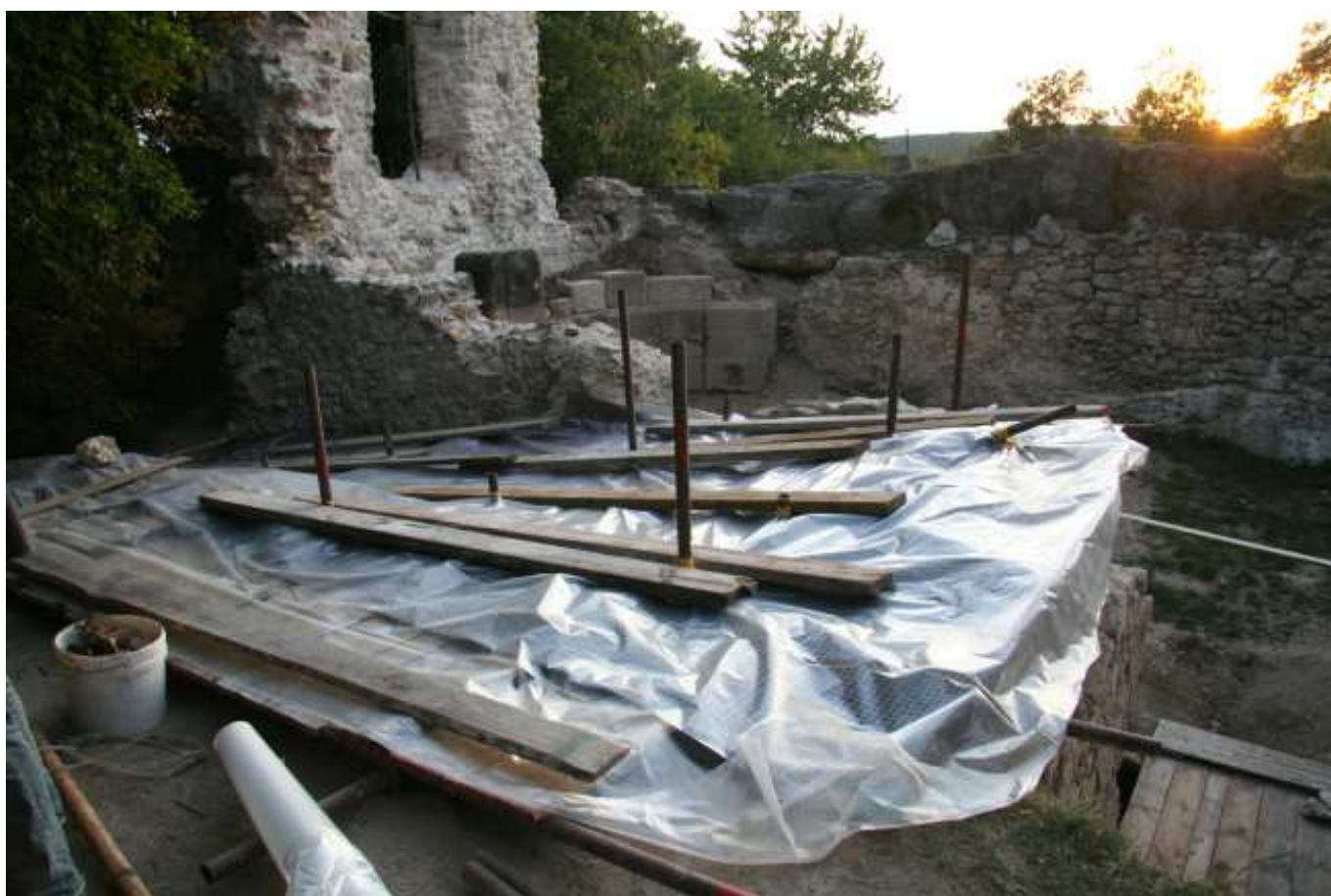
Obr. 44 Archeologická sonda zakrytá pomocou lešenárskej konštrukcie, ktorá je prekrytá izolačnými fóliami na odvod zrážkovej vody mimo sondy, 2008.
