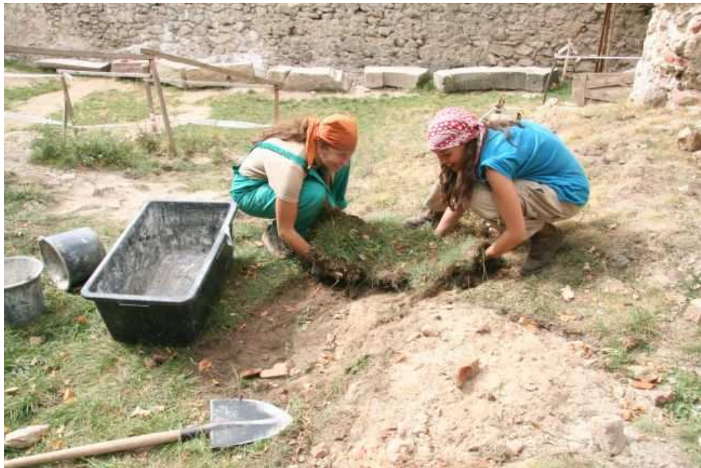
Obr. 30 Na biosanáciu korún múrov boli použité aj trávnaté koberce zo zeme bezprostredne pod múrmi na prevažne deštruovanej sutine vápennej malty, 2009.
