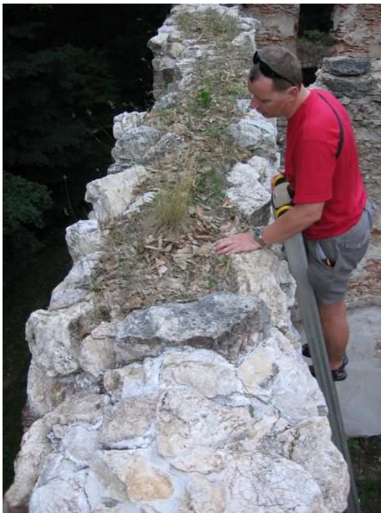
Obr. 29 Južný múr južnej časti kláštora - experiment s rôznymi spôsobmi riešenia koruny murív vrátane zatravnovania - kontrola stavu statikom I. Holubom, 2006.
