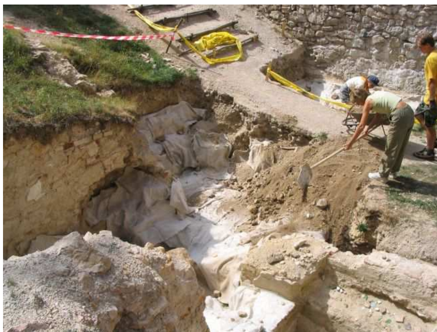
Obr. 42 Zazimovanie archeologického náleziska prekrytím geotextíliou a prisypáním, 2003.
