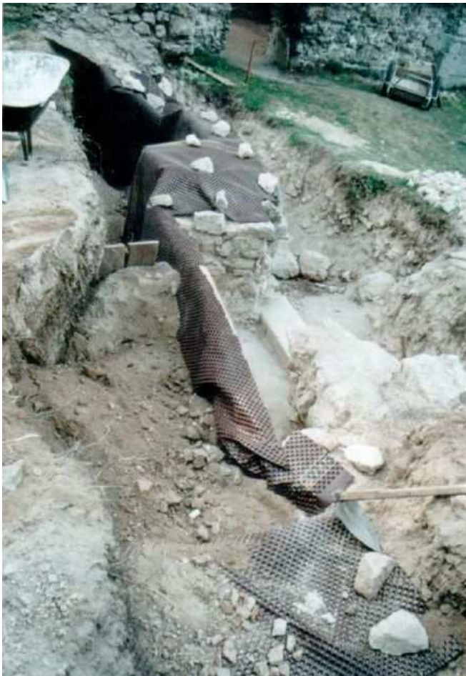
Obr. 39 Zасыpanie odkrytého múru hydroizolačným platónom - nopovou fóliou, 2001.
