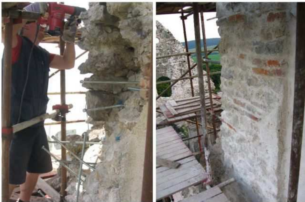
Obr. 25 Kotvenie šošovkovitej deštrukcie nárožia veže - osádzanie kotviacich tyčí, na ktoré bolo namurovávané nové murivo a finálny stav po doplnení muriva, 2005.
