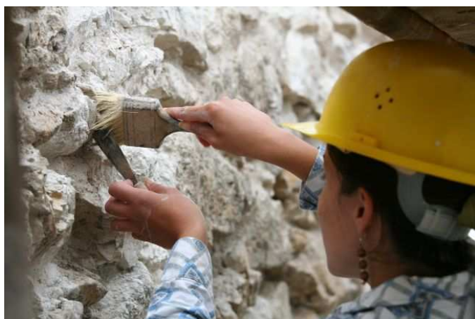
Obr. 21 Dotlačanie malty do vyčistenej a navlhčenej škáry pomocou štetca, 2009.
