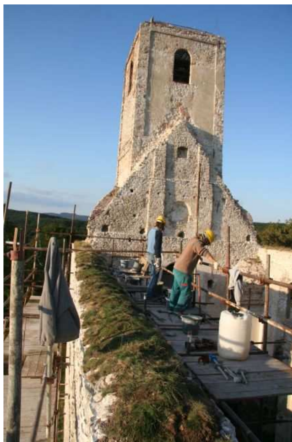
Obr. 34 Koruna západného múru lode kostola - finálny stav po zatrávnení, 2009.
