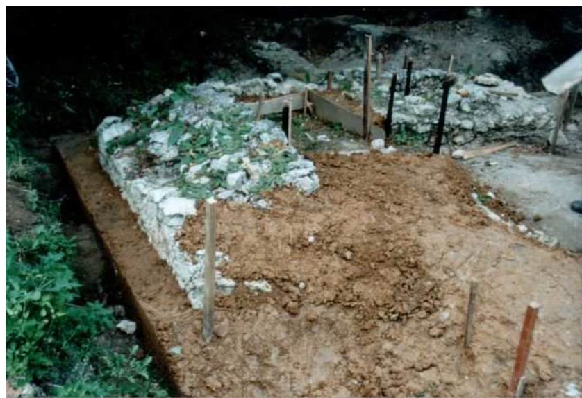
Obr. 38 Konzervácia opätovne zasypaných archeologických murív ílom, 2000.
