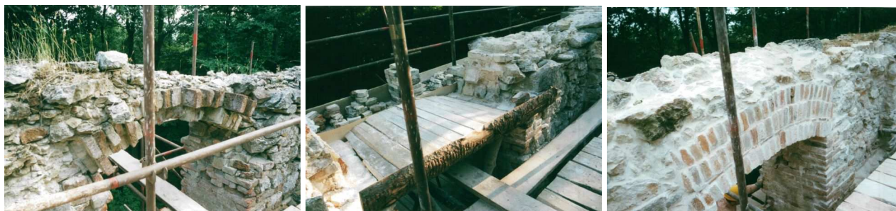
Obr. 23a Rekonštrukcia záklenku okna na druhom podlaží kláštora – stav pred zásahom, 2003.
